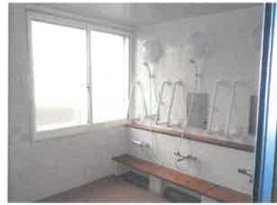
改修棟居室棟 大浴室
